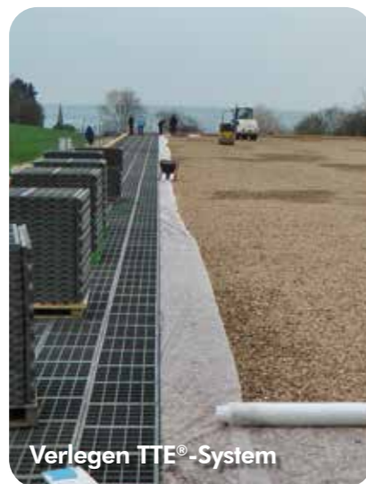
Aufbringen der Tretschicht
